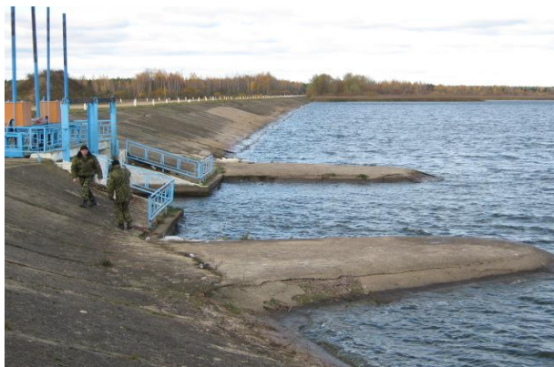
Водозабор на Любанском водохранилище
