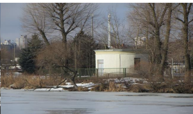
Водозабор Чижовского водохранилища
