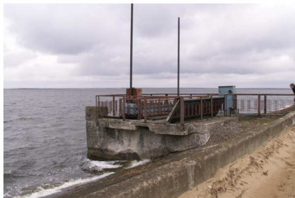
Водозабор на водохранилище Локтыши
