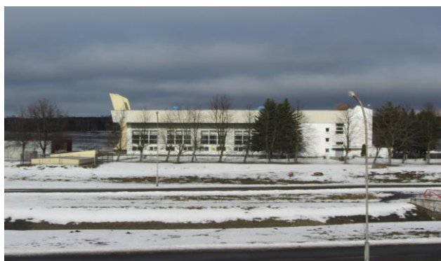
Водозабор водохранилища Дрозды
