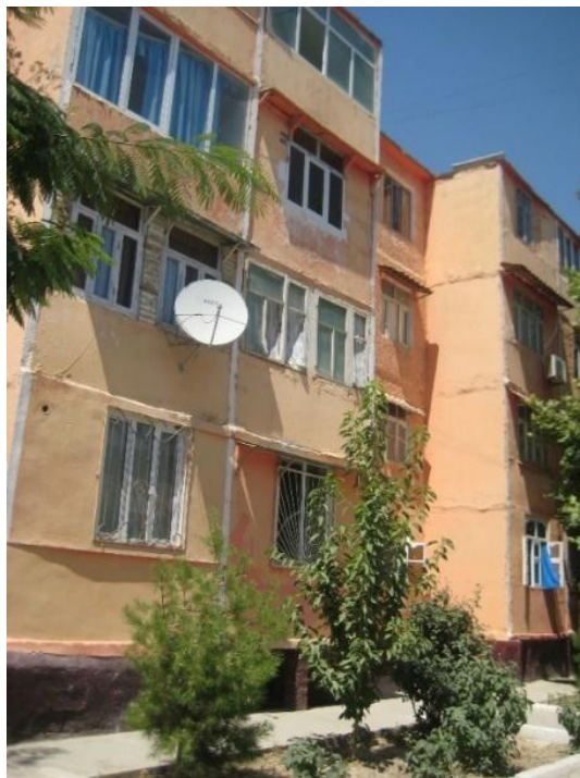
Рис. 7. Вид четырехэтажного крупнопанельного жилого дома.
